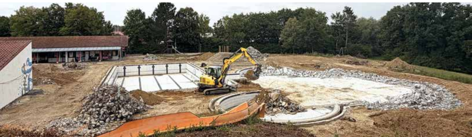
Das Becken-Gelände des Freibads ist mittlerweile eine Großbaustelle.
