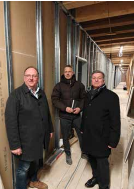
Im Februar war Bauminister Christian Bernreiter (rechts) zu Besuch auf der Groß-Baustelle und zeigte sich wie Bürgermeister Herbert Lichtinger (links) begeistert von dem gewaltigen Sanierungsprojekt, das ihnen Bauleiter Jörg Hinterberger (Mitte) von der Firma BAUART vorstellte.
